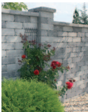
Falak és kerítések
